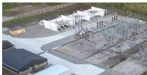
Photo du terrassement pour création des loges TR312 + TR 313 – Photo du poste source suite à la réalisation des travaux
