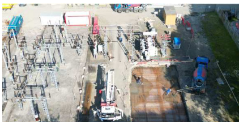
Photo du terrassement pour création des loges TR312 + TR 313 – Photo du poste source suite à la réalisation des travaux
