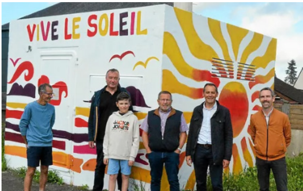
Inauguration de l'embellissement d'un poste de distribution à Trégueux en présence du DST, Thomas Touboul, des élus de la commune et de l'Interlocuteur Privilegié d'Enedis, Cyrille Moisan
